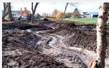
Travaux sur Le Négron © SBM
